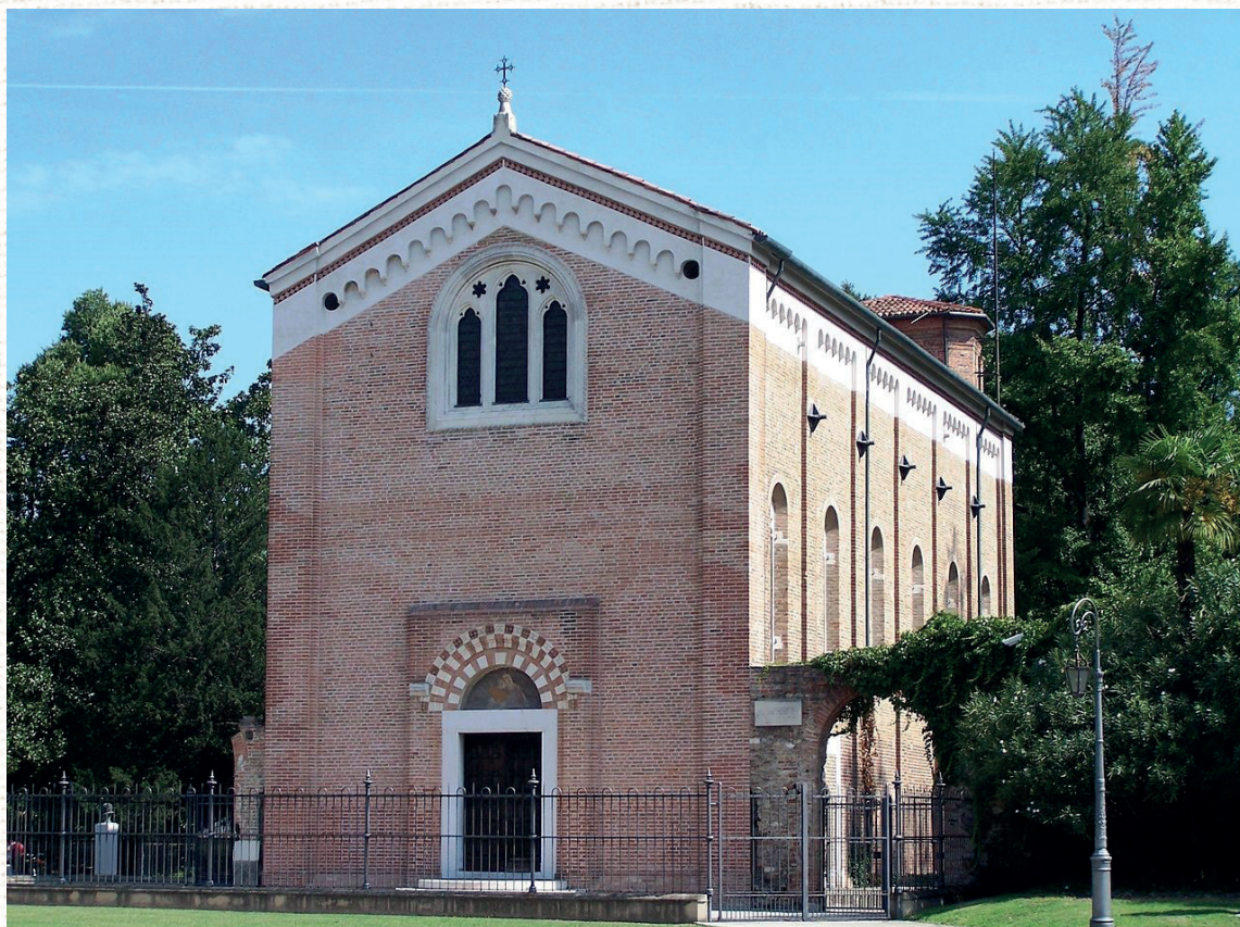
Obr. 21: Arena kaple, Padova.
